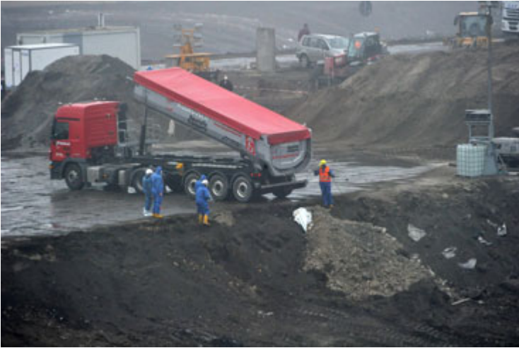
Foto des Abkippvorgangs einer „Testfahrt“ auf die Deponie Ihlenberg, Kipphöhe ca. 4 Meter.
